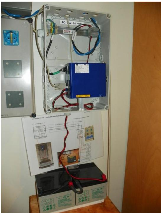
Abb. 20: DC-USV mit AkkuTEC 2412 VdS (Nmg Raum 1)
