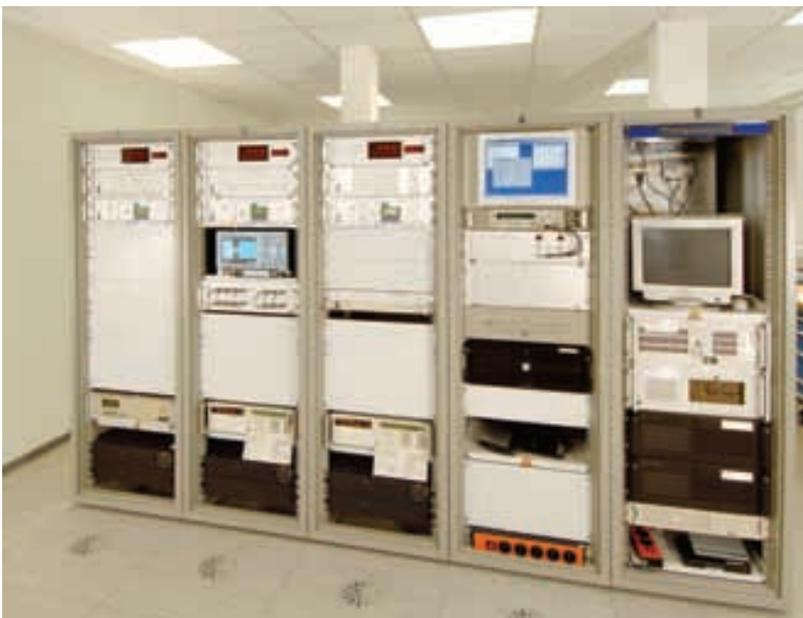
Bild 7: Neue Steuereinrichtung für die Erzeugung und Aussendung des DCF 77-Langwellenzeitsignals
