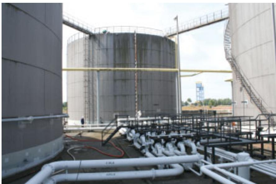
Bild 7: Typischer Lagerbehälter für ruhende Flüssigkeiten (z. B. Mineralöle) mit einem Durchmesser von 23,0 m, einer Mantelhöhe von 15,6 m und einem Volumen von ca. 6 500 m<sup>3</sup>
