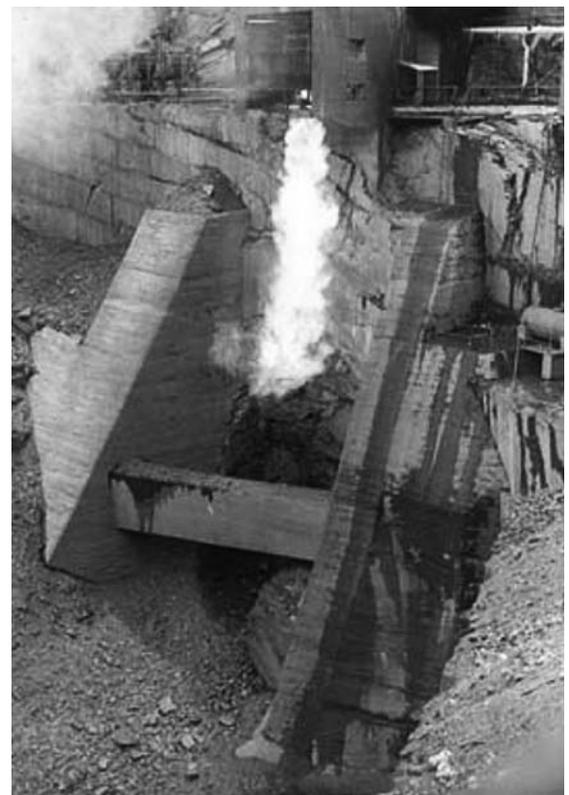
Die Schiefergrube Oertelsbruch eignete sich ideal für das Testen der V2-Triebwerke. Entlang der durch den Abbau entstandenen Schrämmwand konnten Prüfstände angebracht werden, ohne dass Abgasumleiter eingebaut werden mussten. Ein Original-Triebwerk der A4 ist im Museum der Gedenkstätte Laura ausgestellt. (Quellen: <http://www.jena1806.com/> und KZ-Gedenkstätte Laura)
