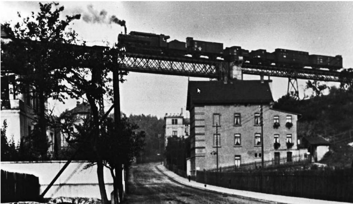
Die Züge aus Berlin mit den Laborgeräten erreichten Weida über den Oschütztal-Viadukt. Der Gitterträger ist zum Teil auf Pendelstützen gelagert, welche den durch Temperaturschwankungen hervorgerufenen Längenänderungen der Träger folgen können. (Quelle: Silbermann)
