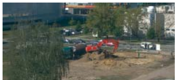
Bild 1: Baubeginn beim Willy-Wien-Laboratorium
