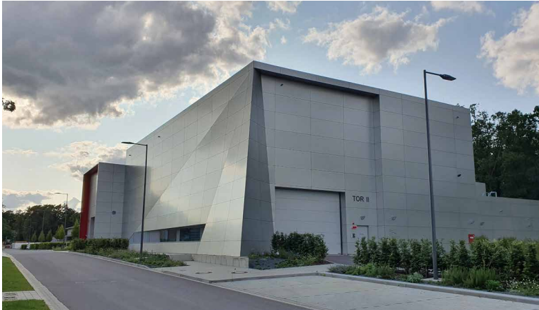
Abbildung 1: Das PTB-Kompetenzzentrum für Windenergie (CCW) – 2020 wurde der etwas zurückgesetzte Euler-Bau II mit seiner charakteristischen „Segel-Ecke“ fertiggestellt; im linken Teil des Bildes ragt der bereits seit 2017 fertige Euler-Bau I hervor.
