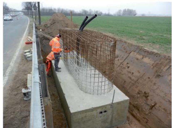
Vormontage der Systemtechnik am Standort Halle
