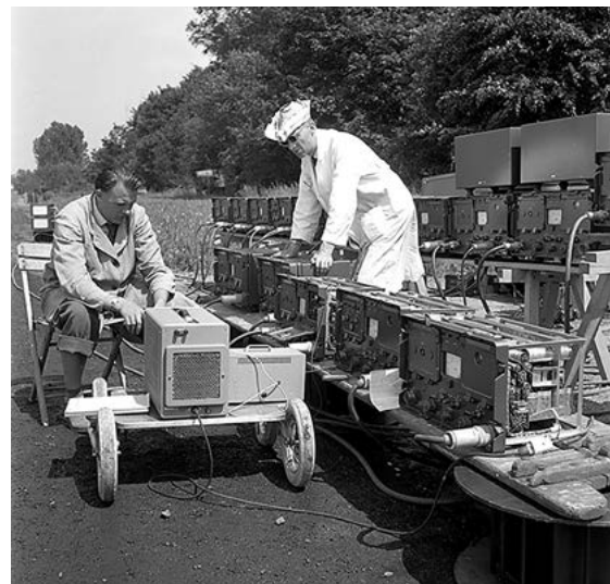
Bild 5: Impressionen von der Eichung von VRG-2-Geräten, damals noch von der PTB unter dem Titel „Beglaubigung“ durchgeführt. Man beachte das Kinderwagengestell zum Transport der Messtechnik sowie den innovativen Sonnenhut. Die Prüfinfrastruktur und Geräteausstattung der PTB, ebenso die Ausrüstung der Mitarbeiter, wurden im Laufe der letzten sechzig Jahre stetig verbessert.
