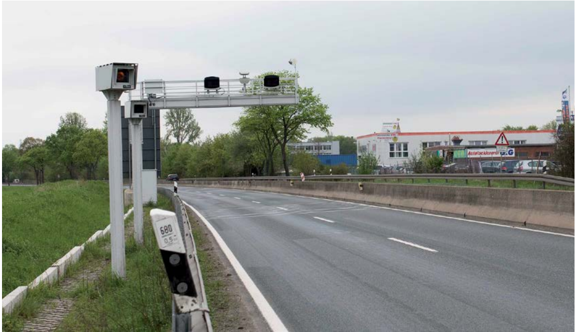
Bild 3: Blick auf das Ausfahrtsportal der Pilotanlage. Man erkennt den Kragarm, der Laserscanner und Spurkamaseras trägt. Am linken Bildrand sind das Blitzlicht und die Kamera für das Heckfoto zu sehen, das von Schnellfahrern erstellt wird. Außerhalb des Bildausschnitts stehen Kameras und Blitzlicht für das Frontfoto.
