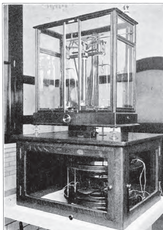
Figura 2: Balanza de corriente en el NIST 1912. En el compartimento superior hay una balanza de brazos iguales, en el de abajo está la bobina magnética que cuelga del brazo derecho de la balanza [4].
