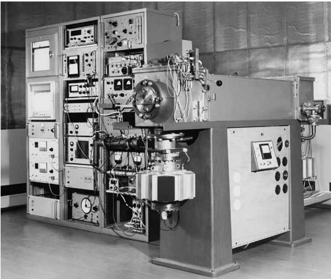
Figura 2: El reloj atómico primario de haz CS1 en la sala de relojes atómicos del PTB (1969).
