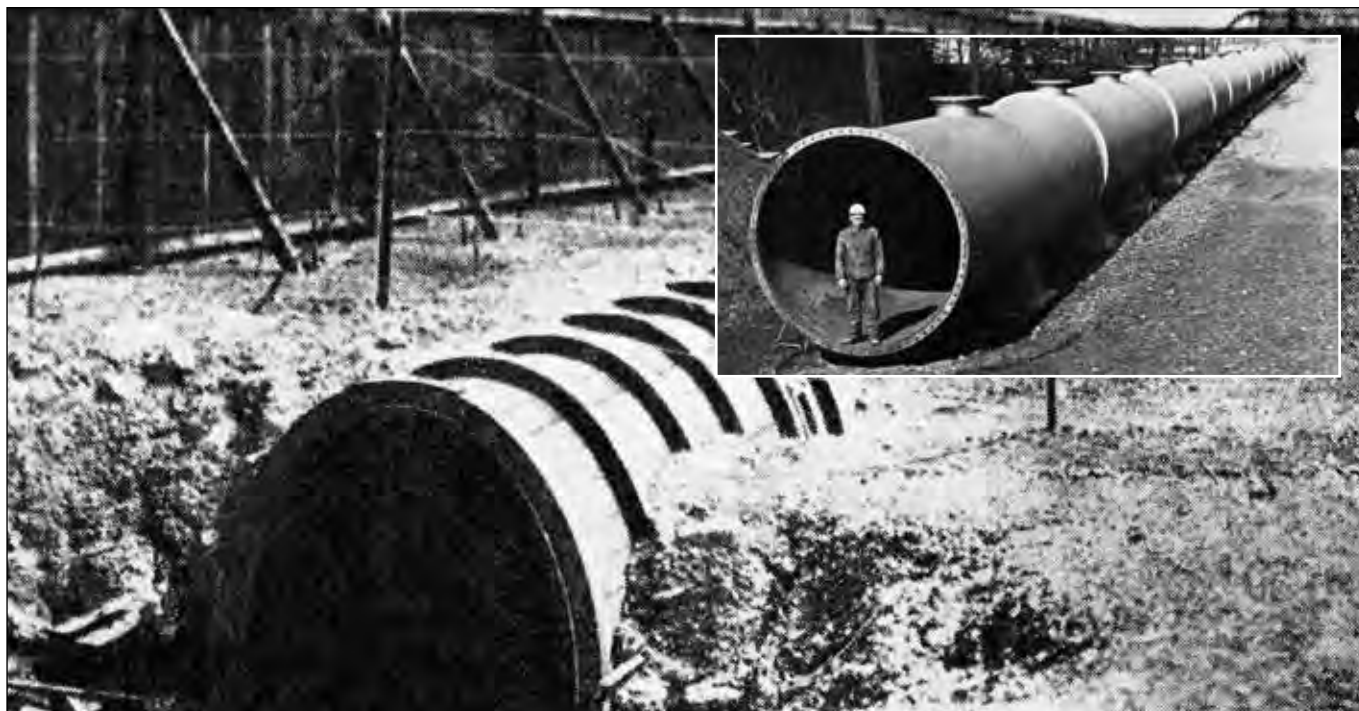
Bild 11: Rohrformige Strecken zur Untersuchung von Kohlenstaub-Explosionen auf der BVS; 34-m-Strecke (1894–1910), 200-m-Strecke (ab 1913)
