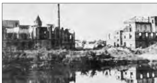
Bild 6: Die zerstörten Gebäude der CTR, 1947
