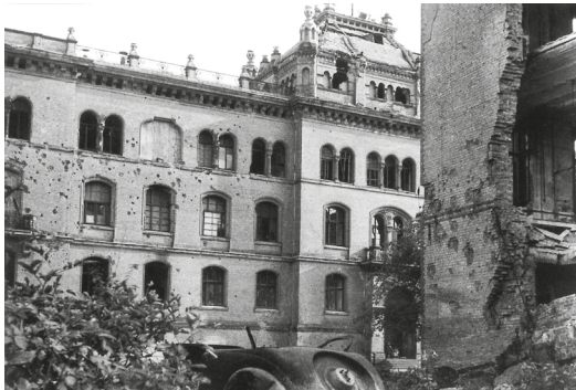
Bild 10: Der stark beschädigte Siemens-Bau 1945
