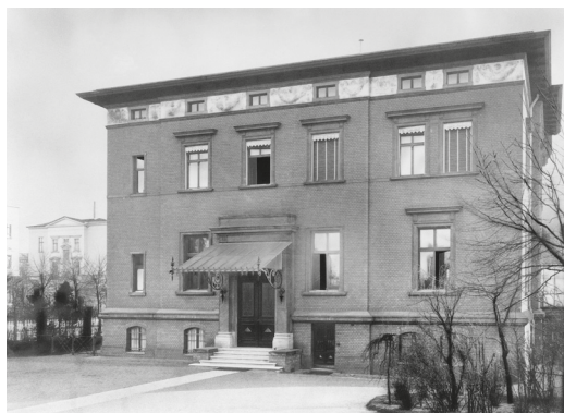
Bild 6: Das Wohnhaus des Präsidenten (nach Kriegszerstörung abgerissen)
