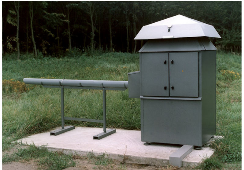
Bild 3: Der Hochvolumen-Luftstaubsammler auf dem Gelände der PTB in Braunschweig.
