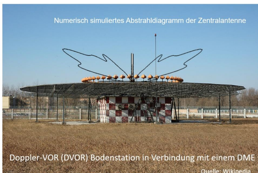
Abbildung 4: Numerisch simuliertes Abstrahlungsdiagramm der Mittenantenne des DVOR.
