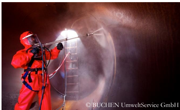
Abbildung 1.2: Innenreinigung eines Behälters mit von Hand gehaltener Spritzeinrichtung 2
